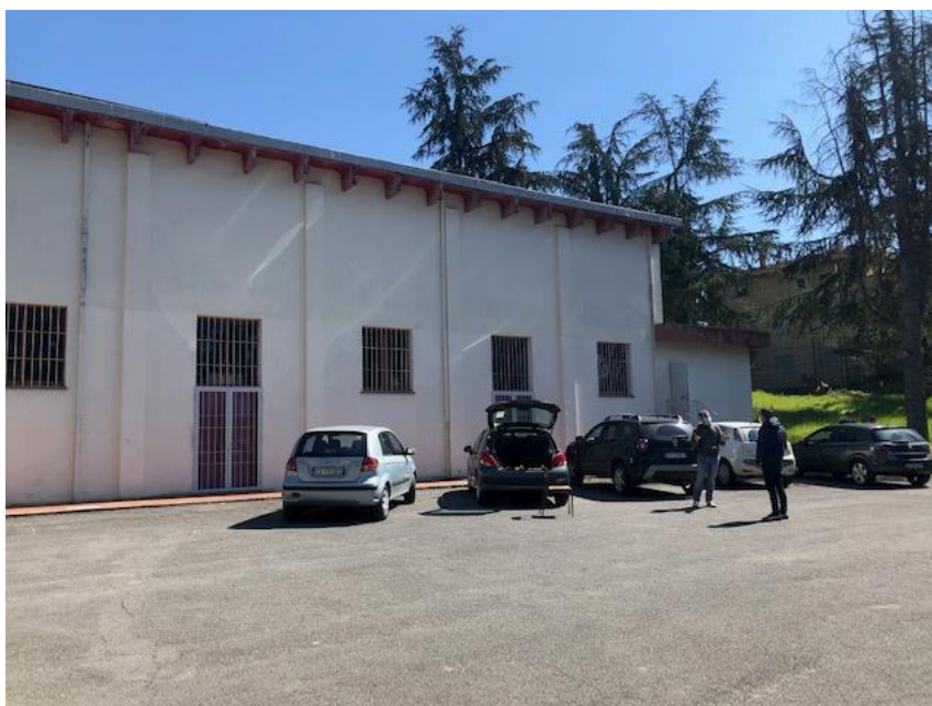
Figura 4 - Sala prove – MARIBANDA – aree esterne
